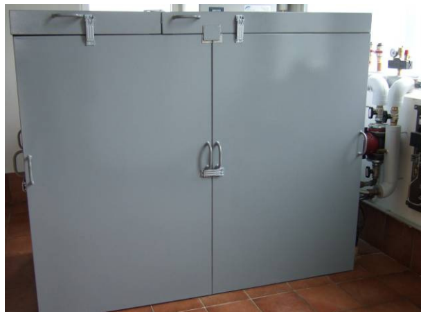
Einhausung der Anlage
